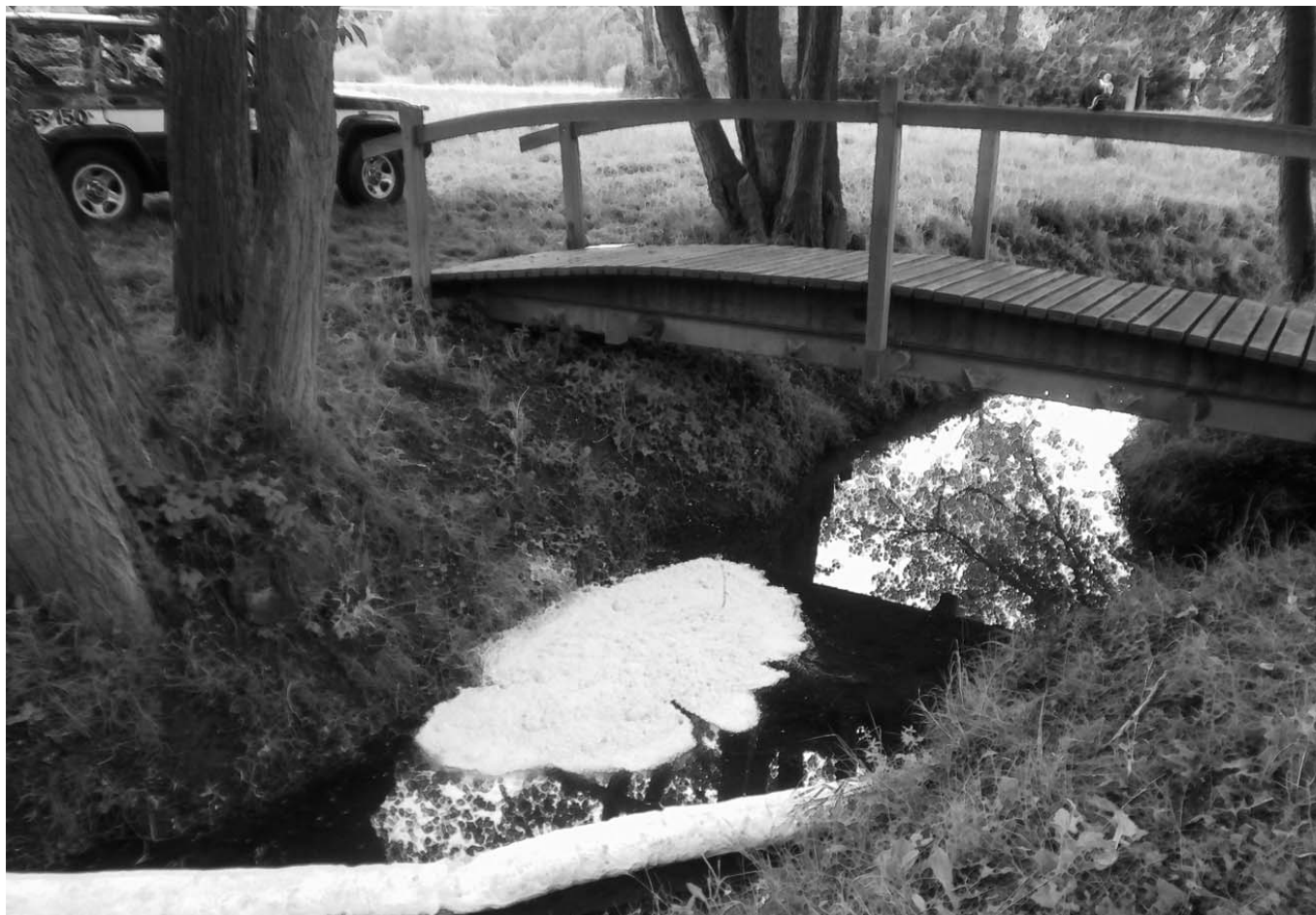
Sanace na potoce u výústě kanalizace
